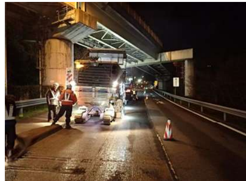
舗装補修工事 作業状況
