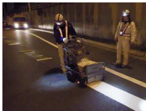
路面標示工事
