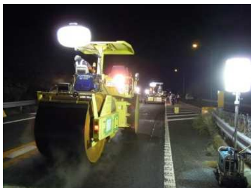
舗装補修工事
