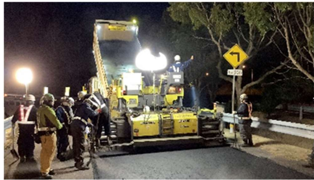
舗装補修工事 作業状況
